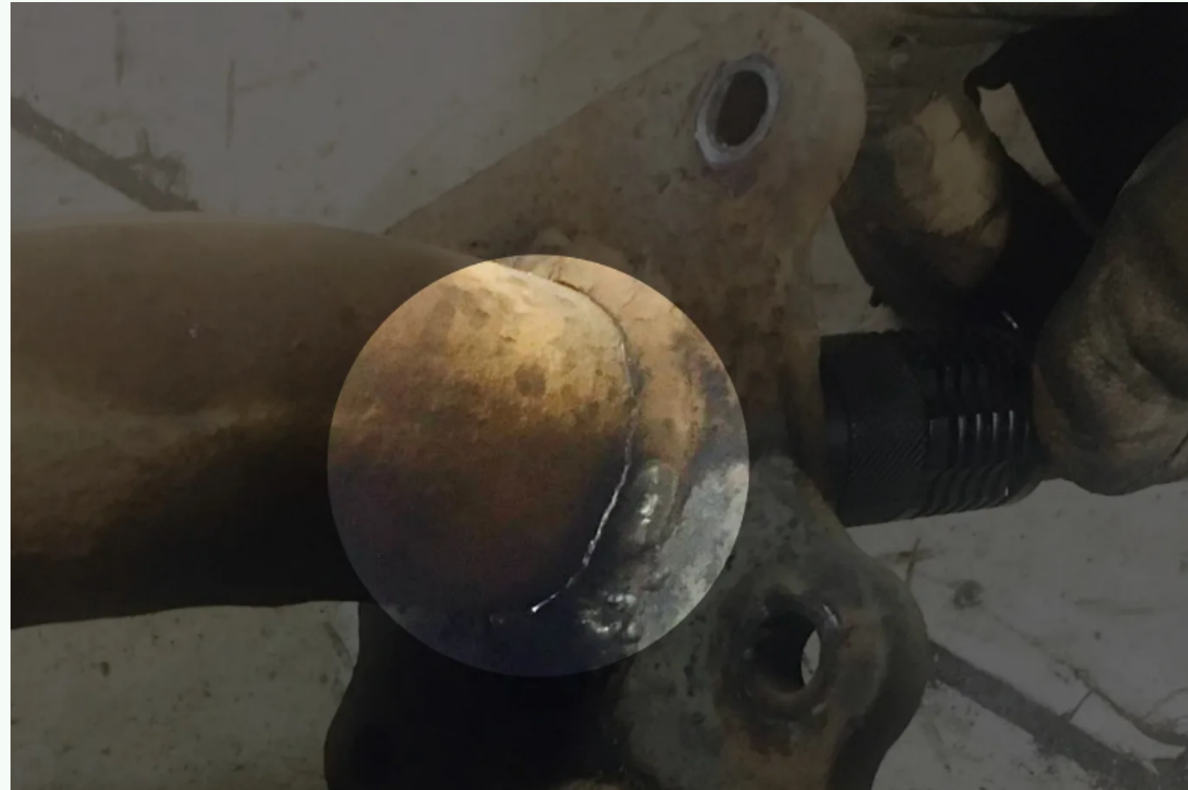
Трещина у основания снятого глушителя
